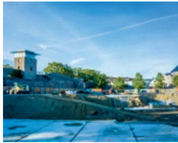
Erdaushub für die Heinrich-Hoffmann-Schule plus Sporthalle & neuer Kita
