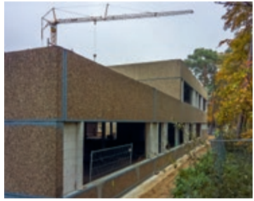
Totalsanierung bis 2022: Wilhelm-Hauff-Schule in Eberstadt
