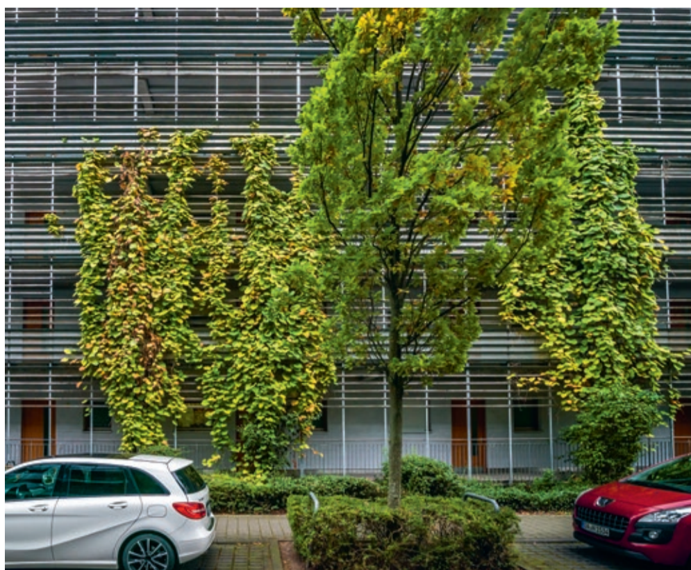
Nicht auf der Hauswand, sondern im wandgebundenen System: Begrünung an Wohnhäusern der bauverein AG in der Bad Nauheimer Straße
